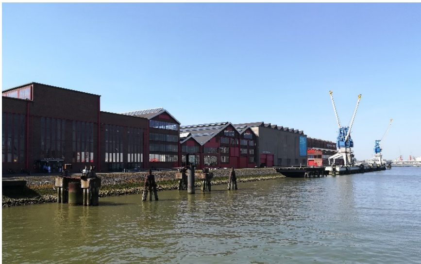
Figure 5. Rotterdamsche Droogdok Maatschappij campus in Rotterdam.
